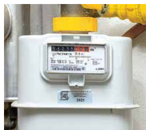
Gaszähler: Nur die schwarzen Ziffern (VOR dem Komma) werden abgelesen.
