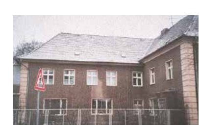
Das Verwaltungsgebäude vor der Sanierung.
