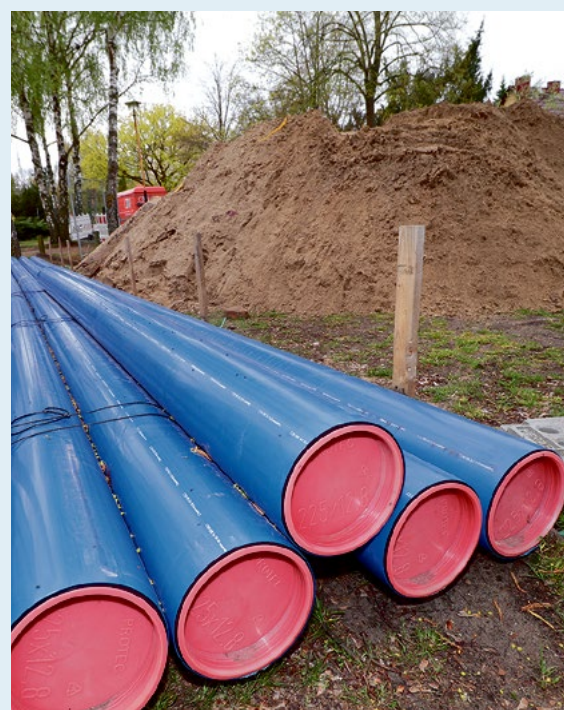
Die neuen Wasserrohre liegen bereit. Fotos(S): SPREE-PR/Petsch
